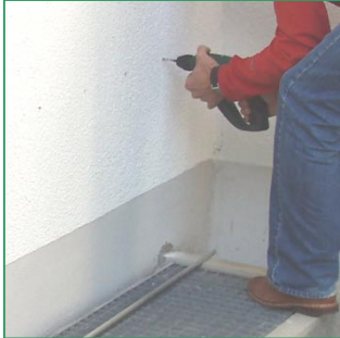
Löcher für Wandleiste bohren – mit Wasserwaage kontrollieren!
