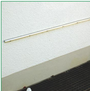
Wandleiste mit passenden Dübeln und Schrauben befestigen.
