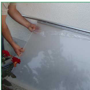
Abdeckung mit Kederband in die Wandleiste einziehen.
